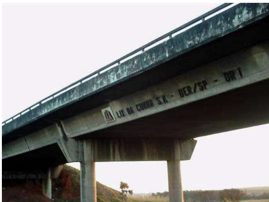
Figura 74 – Superestrutura e tabuleiro de viaduto.
