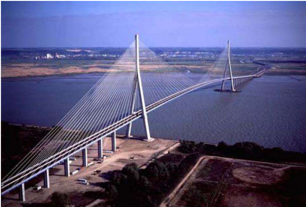
Figura 67 - Ponte da Normandia: Ponte estaiada com duas torres. ( www.matsuo-bridge.co.jp ).
