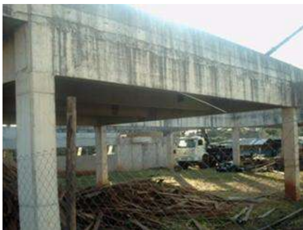
Figura 54 – Exemplo de pórtico no campus da Unicamp.
