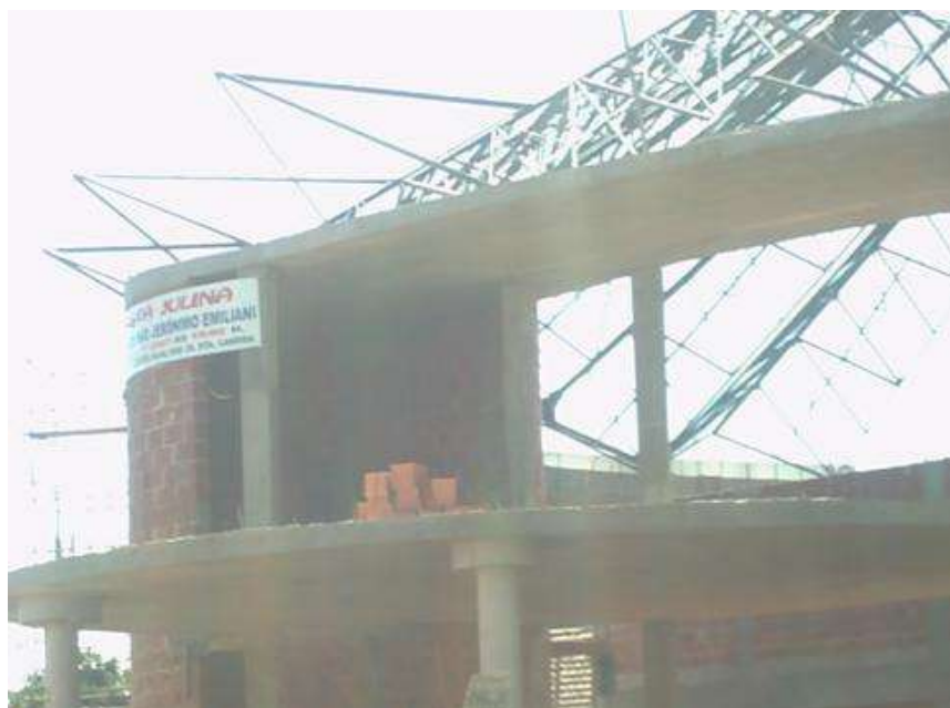
Figura 71 - Laje cogumelo – Canteiro de obra da futura Paróquia São Jerônimo.
