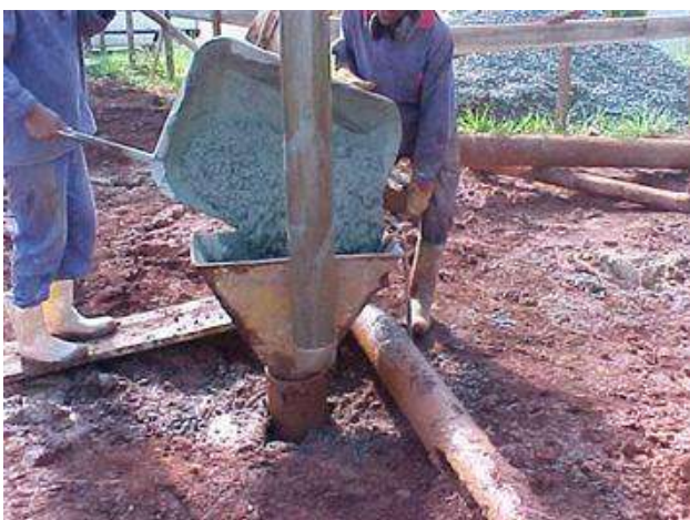
Figura 81 - Concretagem das estacas.
