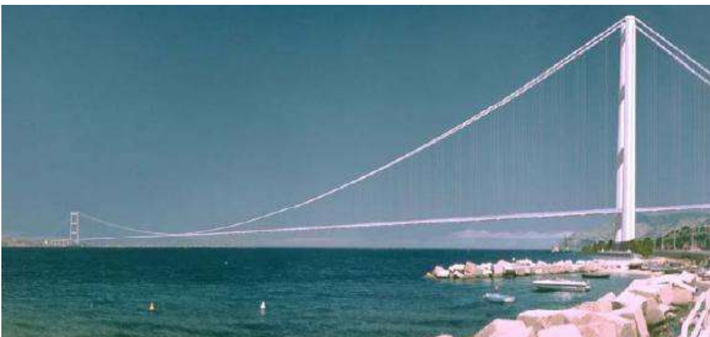
Figura 66 - Ponte de messina: Ponte pênsil com tirantes verticais.
