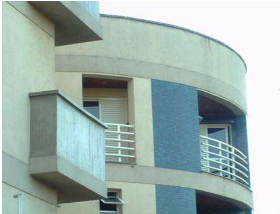
Figura 7 – Viga balcão em concreto armado.
