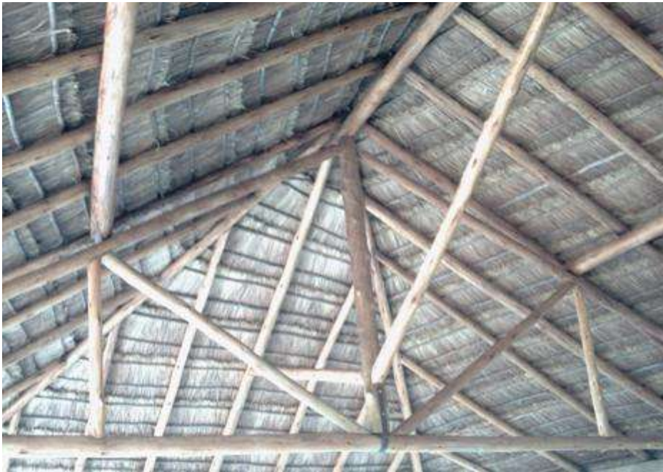
Figura 29 - Tesoura de madeira triangular em duas águas.
