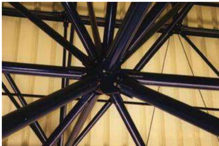
Figura 36 - Detalhe de um dos nós da treliça espacial do ginásio.
