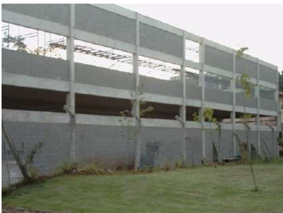
Figura 48 - Estrutura em concreto armado.
