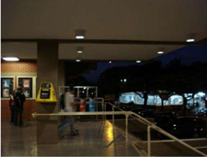
Figura 9 – Viga em balanço no Ciclo Básico
