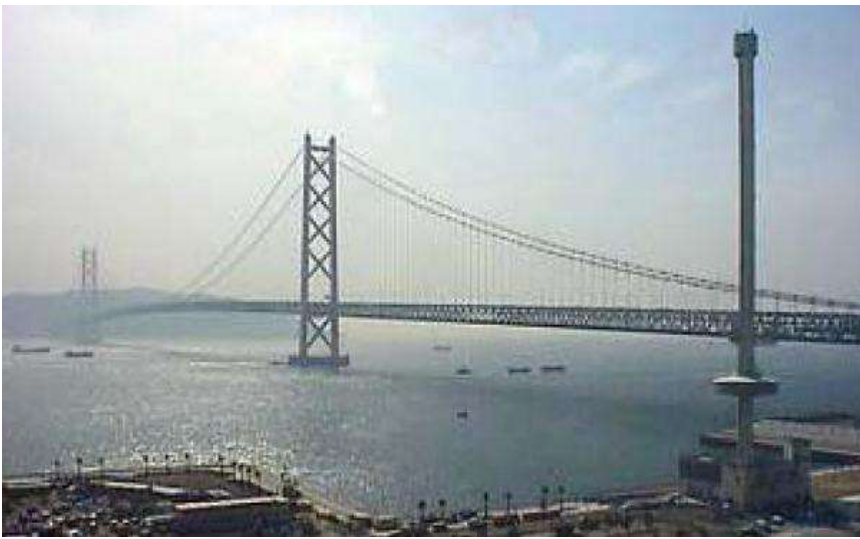
Figura 65 - Ponte Akashi Kaikyo: Ponte pênsil com tirantes verticais e tabuleiro com estrutura treliçada.
