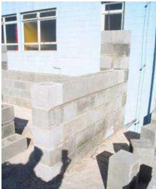
Figura 91 – Esquema de amarração corrente dentada.
