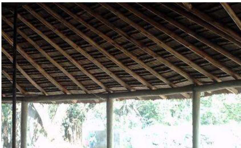
Figura 6 - Vigas de madeira com seção circular.
