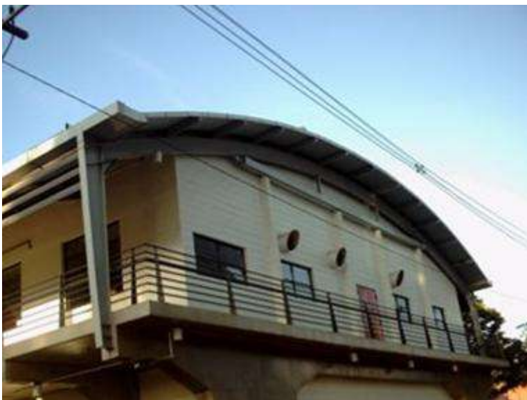
Figura 62 – Arco parabólico biapoiado.
