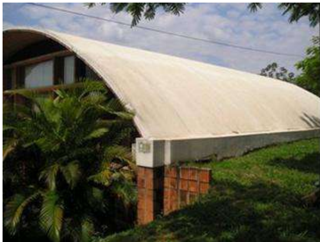
Figura 76 – Detalhe da casca cilíndrica da casa do lago.
