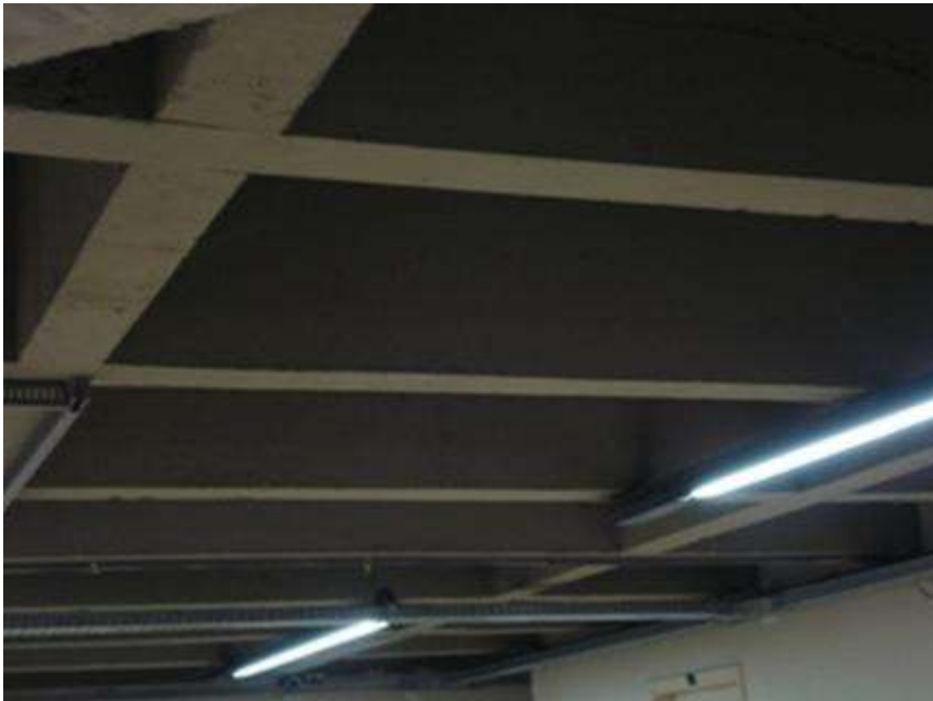
Figura 43 – Exemplo de Grelha no IMECC.
