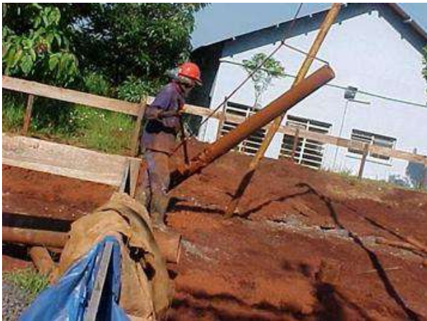
Figura 80 – Colocação dos tubos.
