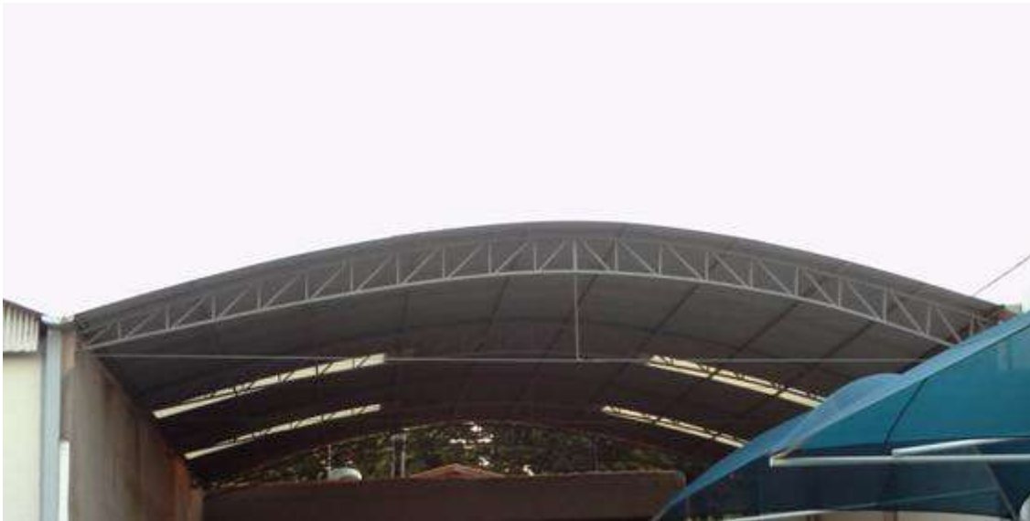
Figura 61 – Arco treliçado atirantado.
