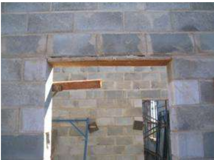
Figura 93 – Detalhe do uso de vergas nas portas e janelas.
