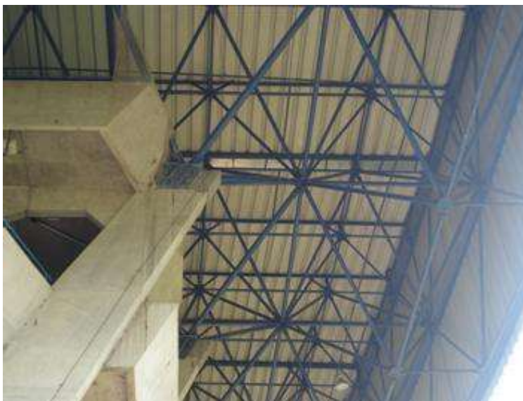
Figura 37 - Treliças espaciais de aço do Ginásio.
