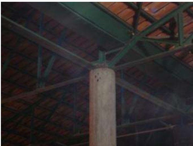
Figura 25 – União entre treliças e pilar.
